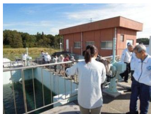
阿見浄水場 処理施設
