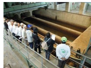
霞ヶ浦流域下水道事務所 処理施設
