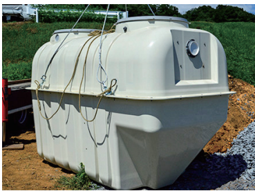
浄化槽は微生物などの働きを利用して水をきれいにする装置です。
