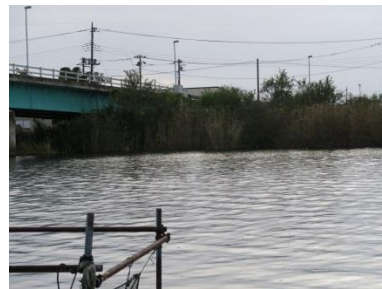
稲敷市古渡橋
