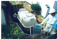
浄化槽の設置
