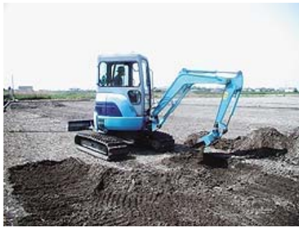
専用バックホーによる表土除去
