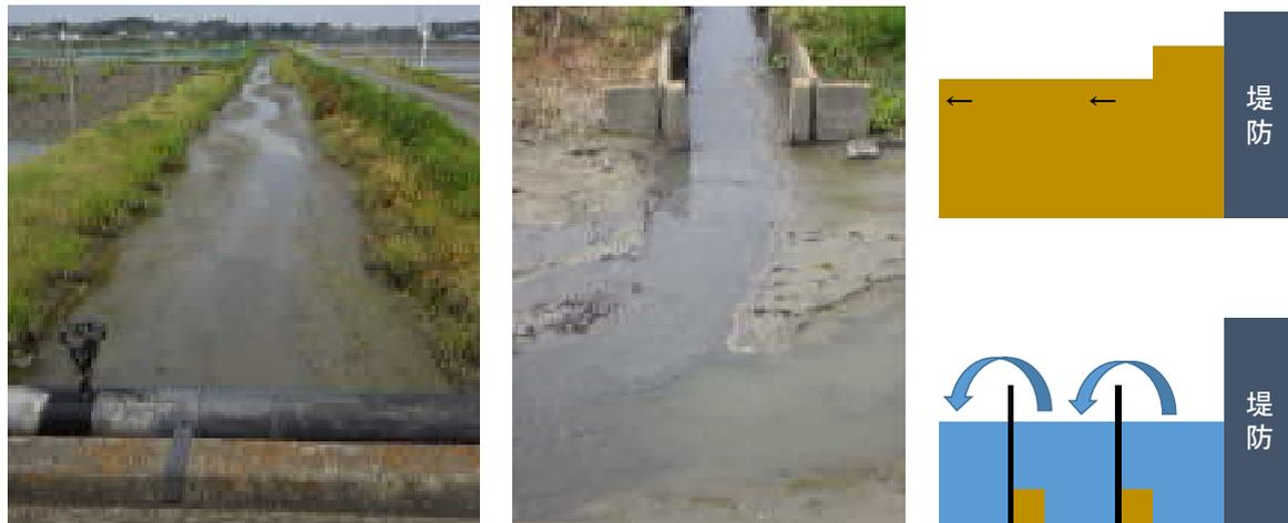
図 18 下玉里地区の排水路。 左：採水地点。深さ 1.2m の通称・大排水路に大量の土砂が堆積。 中：圃場間の水路から大排水路への合流地点。水の流れに伴い土砂の巻き上げが生じている。 右上：現状の大排水路の断面イメージ。堆積した土砂を巻き上げながら排水が流れる。 右下：改善案の大排水路の断面イメージ。土砂を除いた排水路に土留め板を入れ、土砂と水の分離を促す。水は板をオーバーフローして流れ、土砂はその場に堆積する。
