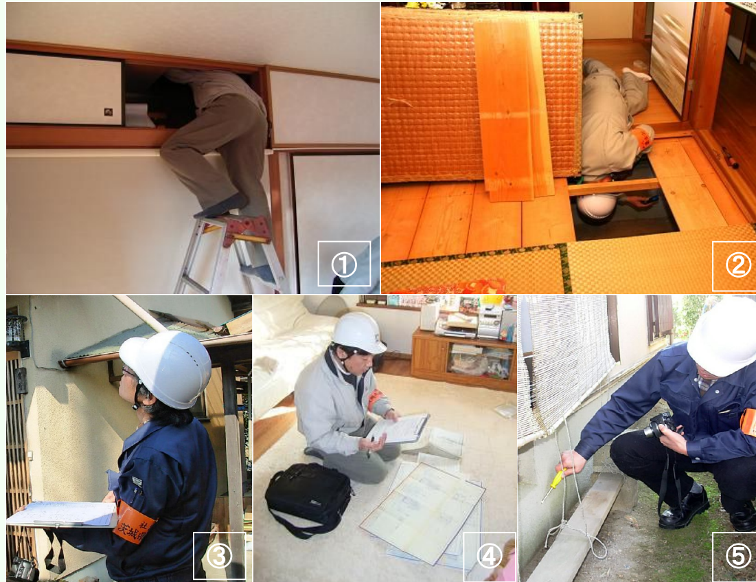
【耐震診断のようす】①小屋裏調査②床下調査③外壁目視調査④既存図面照合⑤基礎打診調査
