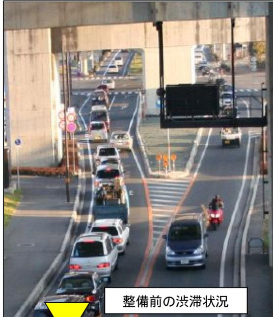
梅香トンネル北側の金町交差点では、朝夕の通勤時間を中心に、常陸太田方面への渋滞が発生していました。渋滞の大きな原因は、当交差点での左折車が直進車を妨害していることでした。このため、左折レーンを新設置し、直進車が交差点を円滑に通行できるようにすると共に、交差点の処理能力を上げました。その結果、梅香トンネル内の渋滞が緩和され、5～6分間かかっていた梅香トンネルの通過時間が**約半分**に短縮されました。
