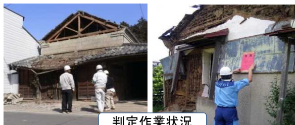
判定作業状況
