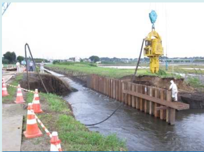
氾濫箇所の応急復旧 【(一社)茨城県建設業協会】
