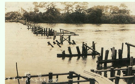
明治26年の初代留橋架橋以来、何度も流失、架橋が繰り返された。写真は昭和16年の洪水で壊れた留橋。
