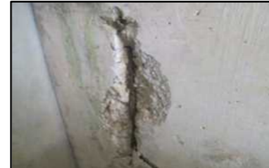
県営住宅 外壁コンクリートの中性化による爆裂（安全性の低下）
