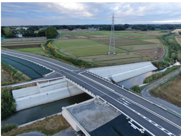
豊坂橋（一級河川豊坂川 渡河部）
