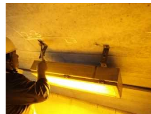
附属物の打音検査の実施
