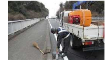
土砂払い 劣化の要因を早期に除去
