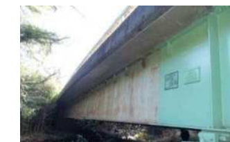
部分塗装 弱点を集中的に補修
