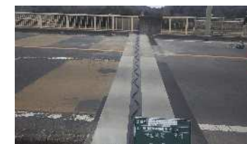
伸縮装置の非排水化 橋梁の劣化を抑制
