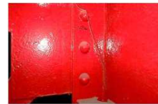
鋼橋の亀裂
