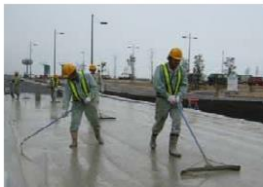
〈グラウト材の注入・充填状況〉
