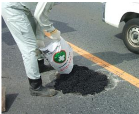
写真 4.4 常温合材による穴埋め
