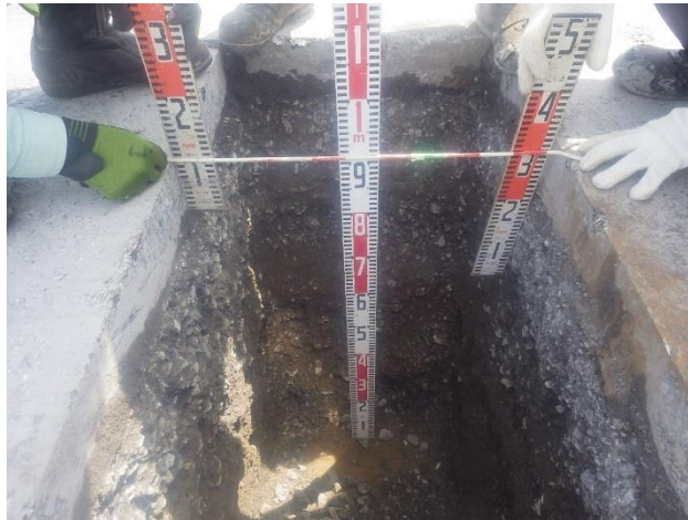
写真 3.1 開削による厚さ・状態確認の一般例
