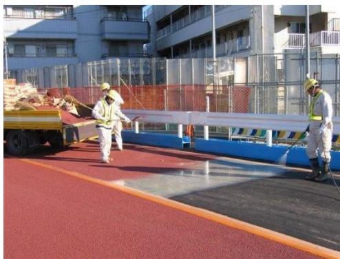
図 4.5 ニート工法の施工状況
