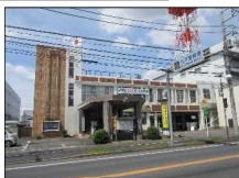
古河警察署現況 (S41年3月築)
