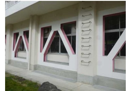
【耐震改修工事例】
