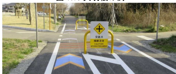
図 7.20 矢羽根・交通安全施設の例(つくば霞ヶ浦りんりんロード)
