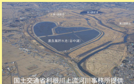
国土交通省利根川上流河川事務所提供 渡良瀬遊水地全景
