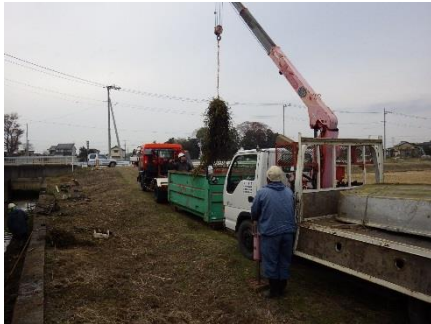
重機による作業の様子
