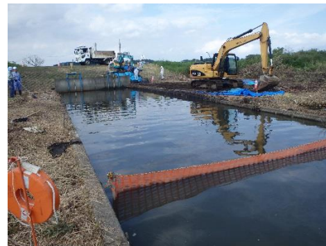
作業後の様子
