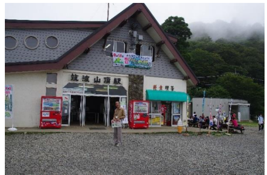
筑波山ケーブルカー 筑波山頂駅外観
