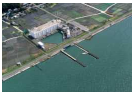
霞ヶ浦揚水機場
