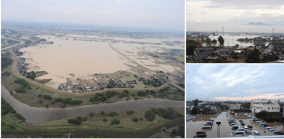
平成27年関東・東北豪雨災害（提供 常総市）
