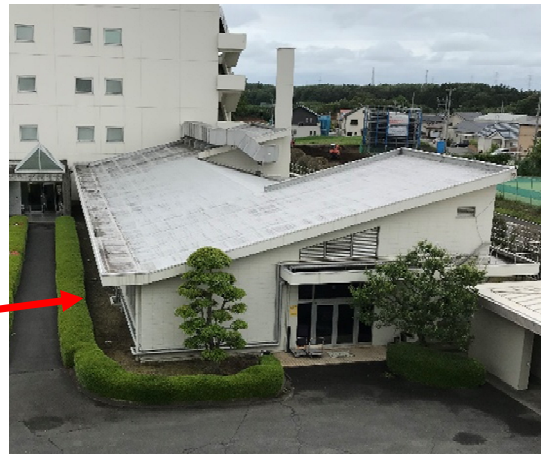
第一実験棟外観写真
