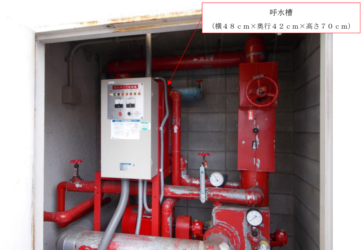
写真2 消火栓ポンプ室内（呼水槽は操作盤裏）
