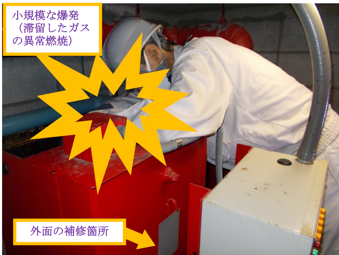
写真3 消火栓ポンプ呼水槽の内面補修時の様子 (模擬)
