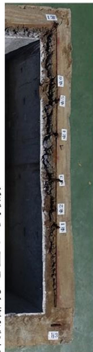
図7 東側部分の写真および模式図 (模式図には、鉄筋の位置関係の推定図も示す)
