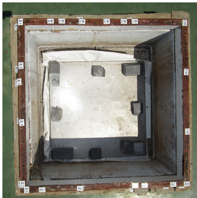
図5 研究棟屋根基礎部に鉄骨部品を載せた状態の写真（上から撮影）および模式図（模式図中に緑色で示す接合箇所位置座標に関しては表1を参照のこと）
