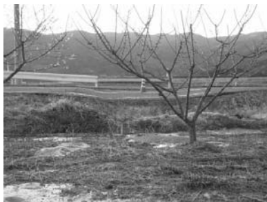
土浦市：フルーツライン陥没
