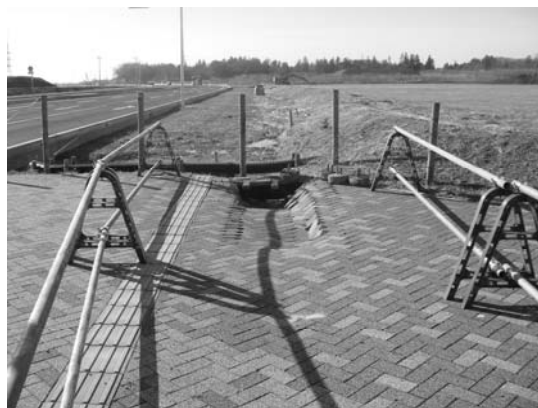
被災した歩道における応急の 安全対策（島名・福田坪地区）
