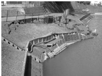
つくば市：大曾根ため池
