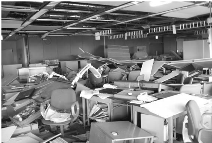
地震直後の執務室の様子
