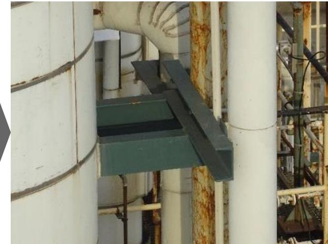
ドローン搭載カメラで撮影した、従来の目視点検で死角となっていた配管の接触部
