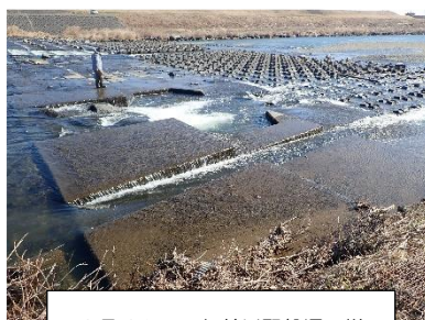
2月21日 久慈川堅磐堰の様子
