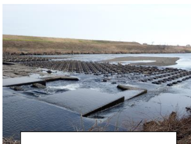
3月16日 久慈川堅磐堰の様子
