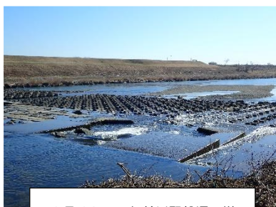
2月28日 久慈川堅磐堰の様子
