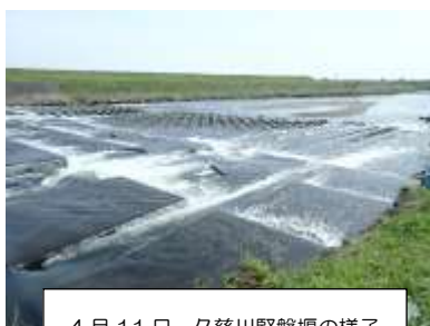
4月11日 久慈川堅磐堰の様子
