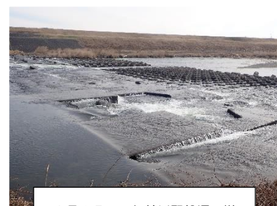
2月15日 久慈川堅磐堰の様子
