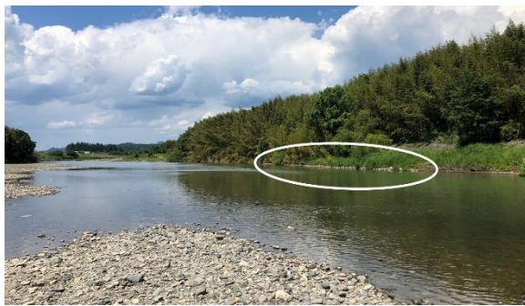
図 3 調査区間の様相 (左奥が上流, 右手前が下流で, 白い楕円は左岸の消波ブロック帯を示す)
