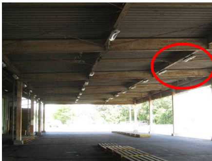
(図1) 集出荷施設の天井に防鳥網を張り、野鳥の侵入や営巣を防いでいる事例 写真: 県西農林事務所坂東地域農業改良普及センター
