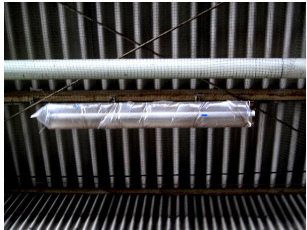
(図1) 集出荷施設の天井に防鳥網を張り、野鳥の侵入や営巣を防いでいる事例 写真: 県西農林事務所坂東地域農業改良普及センター
