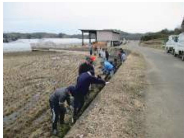
地域住民による泥上げ作業
