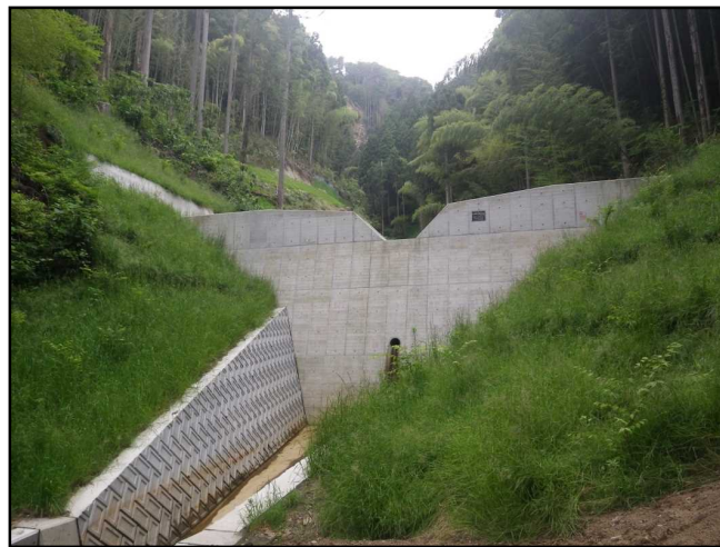
復旧状況（高萩市福平地内）
