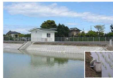
調整池，用水機場，取水口
