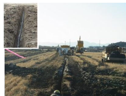
暗渠排水工事の様子
