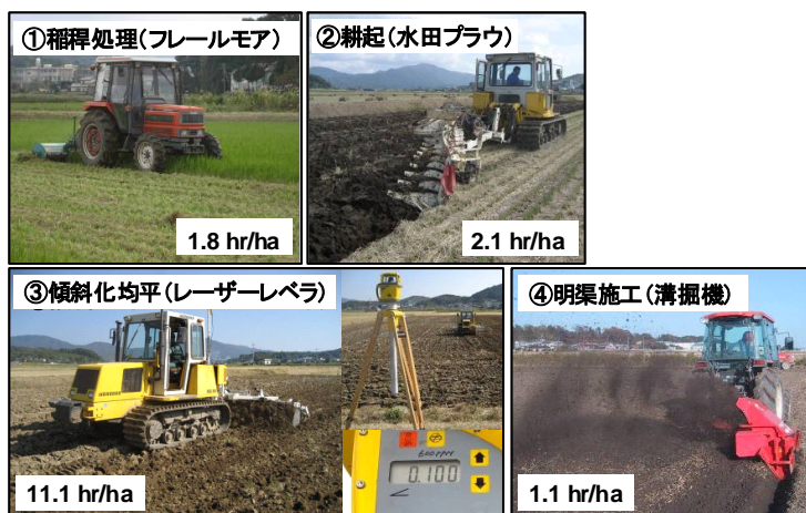
図 傾斜化圃場造成の作業手順と作業時間
