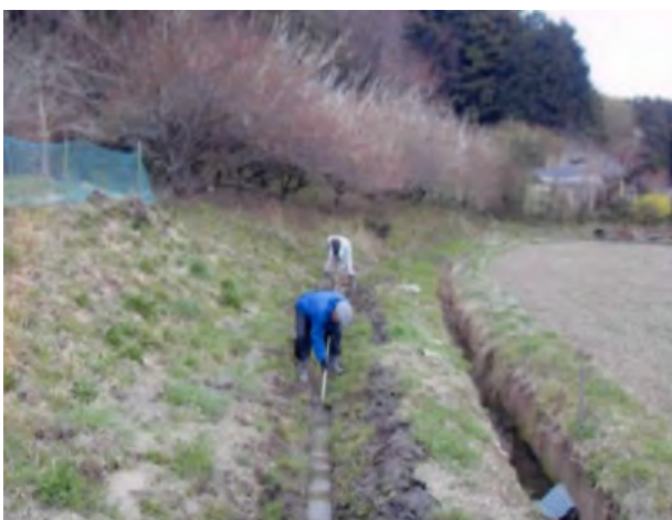
用水路の土砂上げ作業
