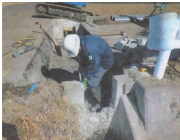
用水路布設替工事
