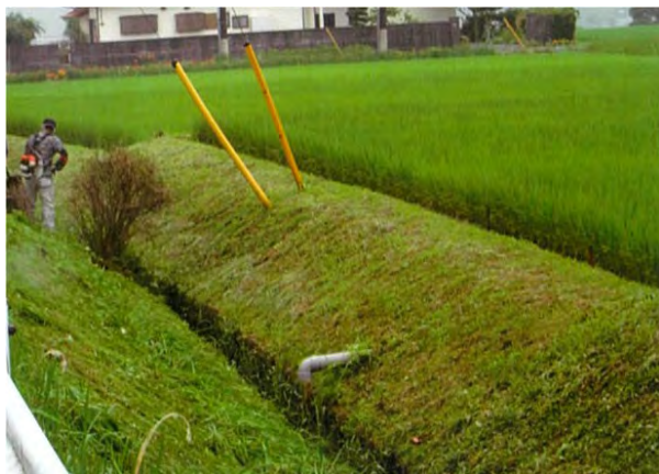
排水路法面の管理
