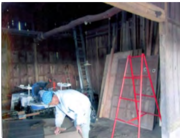
共同利用機械格納庫の修繕
