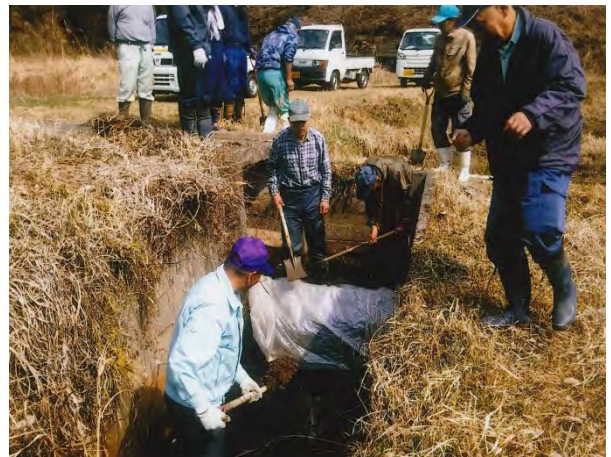
水路の点検・整備
