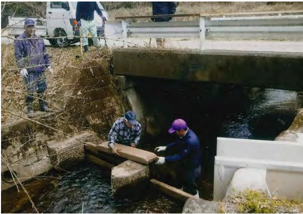
取水口の点検
