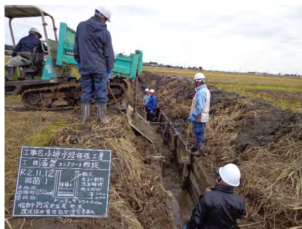
小排水路底盤コンクリート敷設
