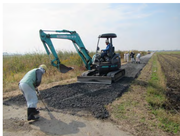
自主施工による農道碎石舗装
