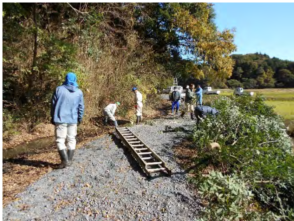
農道砂利敷きと支障木の伐採
