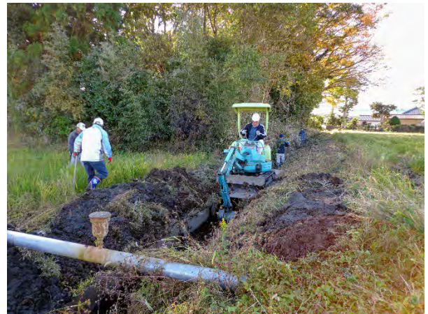
水路の泥上げ
