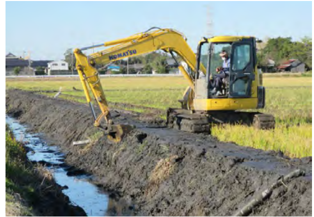
排水路の泥上げ工事
