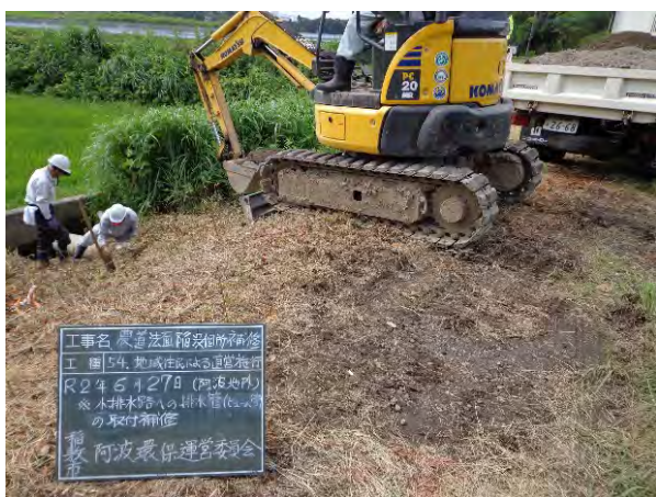
農道法面の補修
