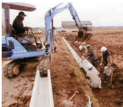
水路の更新 谷河原洪井資源保全向上活動会 (常陸太田市)
