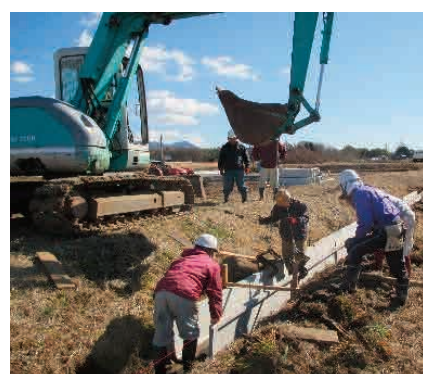
水路の更新 古都環境保全協議会 (筑西市)
