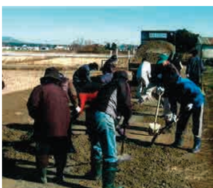
農道の補修 蓮沼・要保全活動組織 (つくば市)
