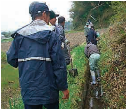
水路の清掃 上ヶ穂集落（高萩市）
