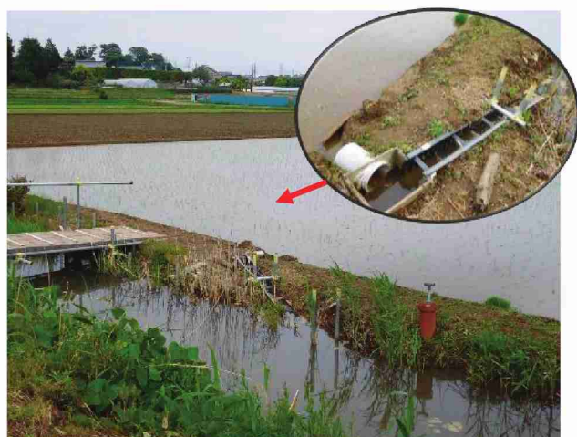
水田魚道の設置
