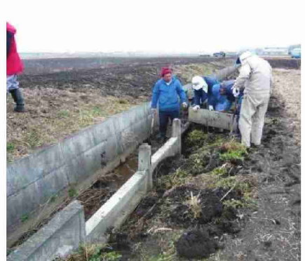
水路の補修 瓜連環境保全クラブ (那珂市)
