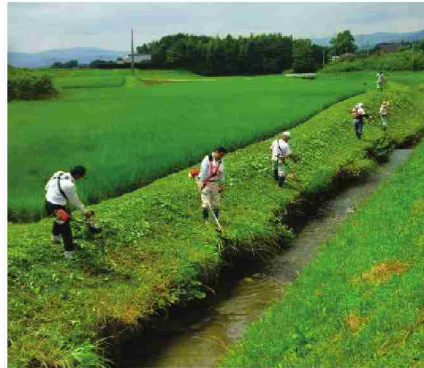
水路脇の草刈り 太田地区資源保全活動組織 (石岡市)
