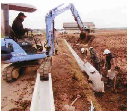
水路の更新 谷河原洪井資源保全向上活動会 (常陸太田市)
