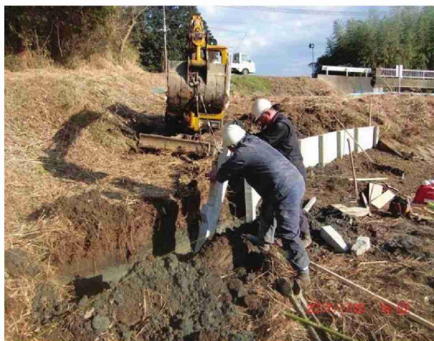
自主施工によるため池護岸
