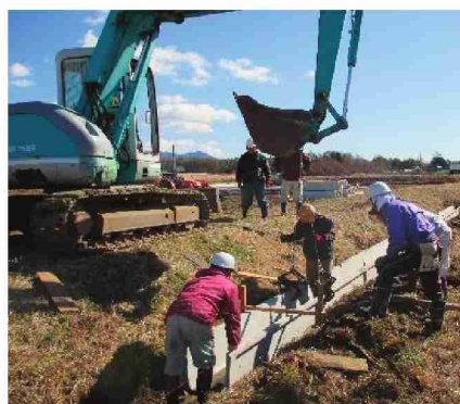
水路の更新 古都環境保全協議会 (筑西市)
