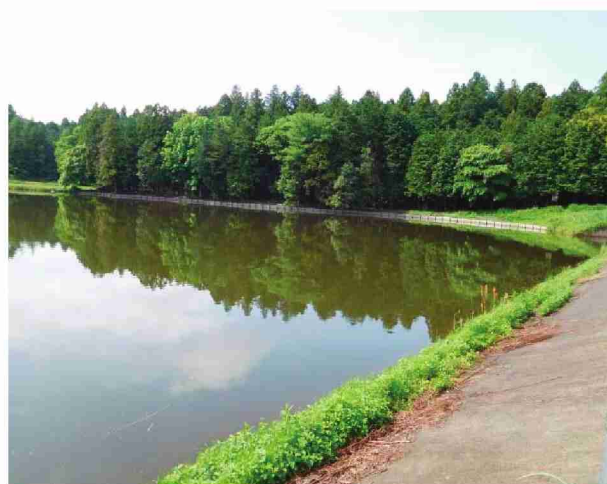
ため池護岸施工後
