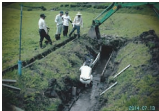
○老朽化した排水路の柵板の更新
