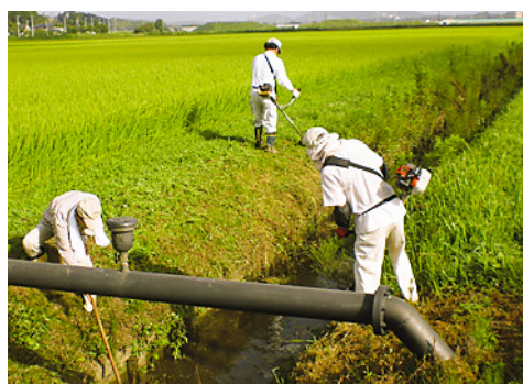
②水路の草刈り
