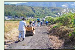
砂利舗装をアスファルト舗装へ (施設の長寿命化)
