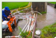
異常気象等後の 見回り・応急措置
