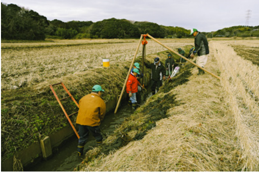
① 水路の泥上げ作業
