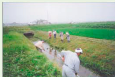
水路の泥上げ (日常の管理)
