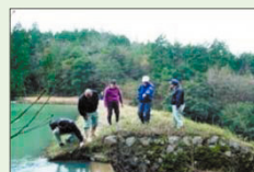
ため池の点検 (日常の管理)
