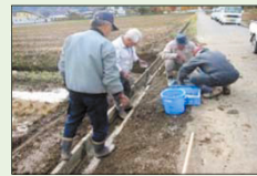
水路の補修 (施設の長寿命化)
