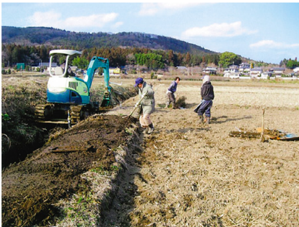
③水路の泥上げ
