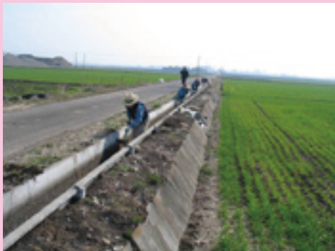
用水路の泥上げ
