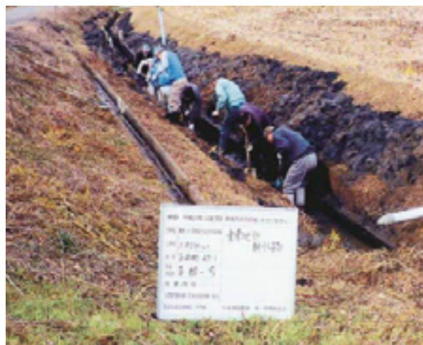
②水路の泥上げ
