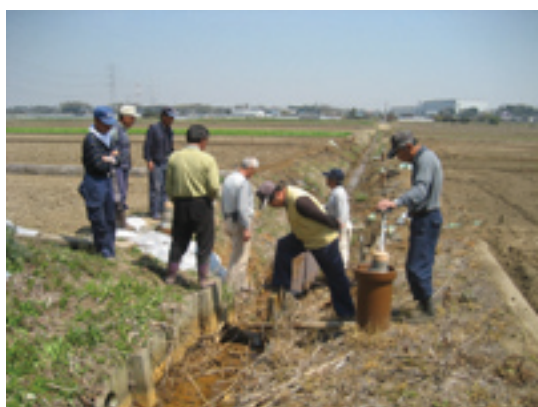
① 施設の点検・機能診断
