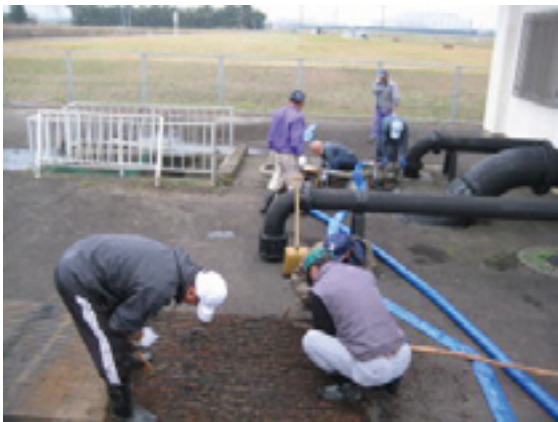
③機場の泥上げ，補修
