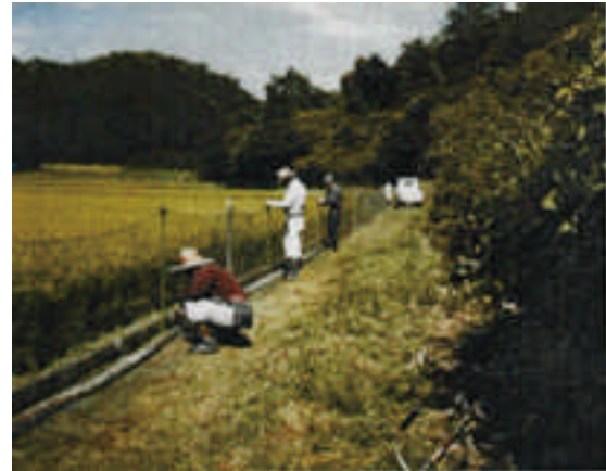
○イノシシ対策用防護柵の設置の様子
