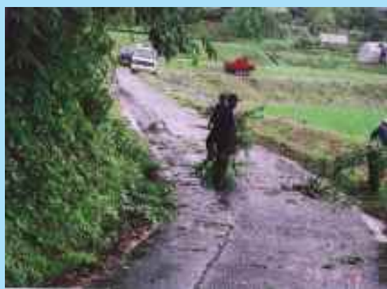
・降雨後の見回りの様子
