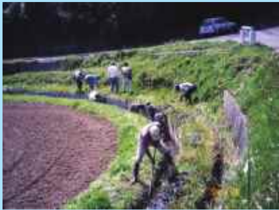
・水路の土砂払いの様子
