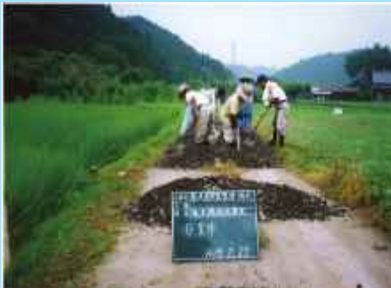
・農道の補修作業の様子
