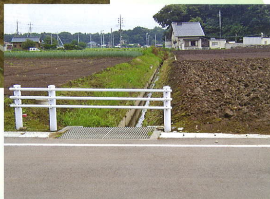
排水路の整備
