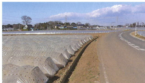
農道と排水路の整備
