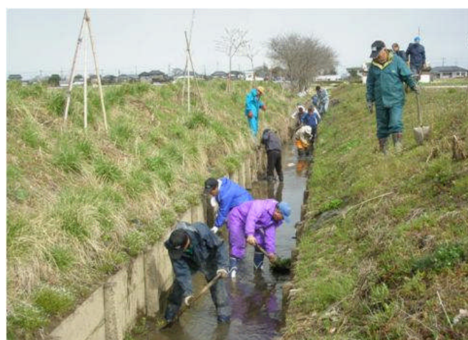
農地・水保全管理支払交付金による活動状況（水路の泥上げ）
