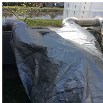
ダクトを利用した炭酸ガスの効率的な局所施用
