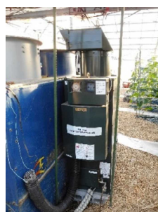
温風ダクトを利用した炭酸ガスの局所施用
