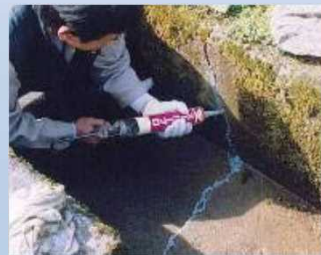
水路のひび割れ補修
