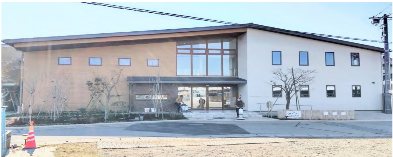
外観 正面入口
